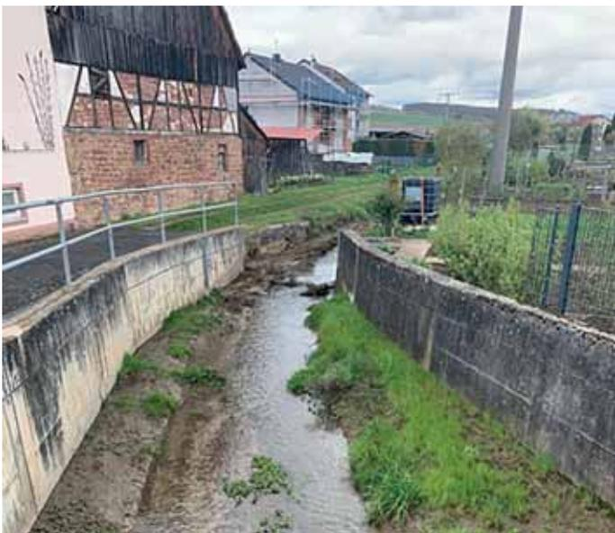
Bekanntermaßen war der Welzbach in der Ortsmitte von Holzkirchhausen bisher aufgestaut. Dies führte zur Anhebung des Wasserspiegels um fast einen Meter, sowie einem Rückstau von über 65 Metern. Durch die Stauung sammelte sich Schlamm an, der regelmäßig von der Gemeinde entsorgt werden musste.
